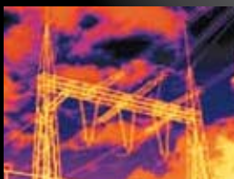
Controllo linee elettriche ad alta tensione
