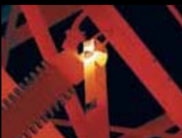
Collegamento non protetto
