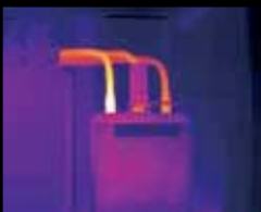
Collegamento difettoso e danneggiamento interno
